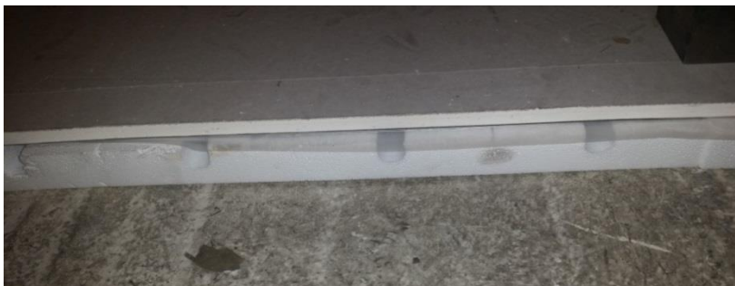
Foto 2.1 Geëxpandeerde PS- plaat met Fermacell lastverdeellaag
