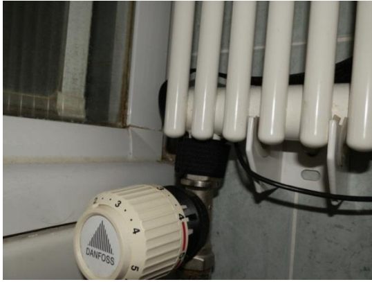
Foto 1.4 Bepaling in- en uitgaande watertemperatuur
