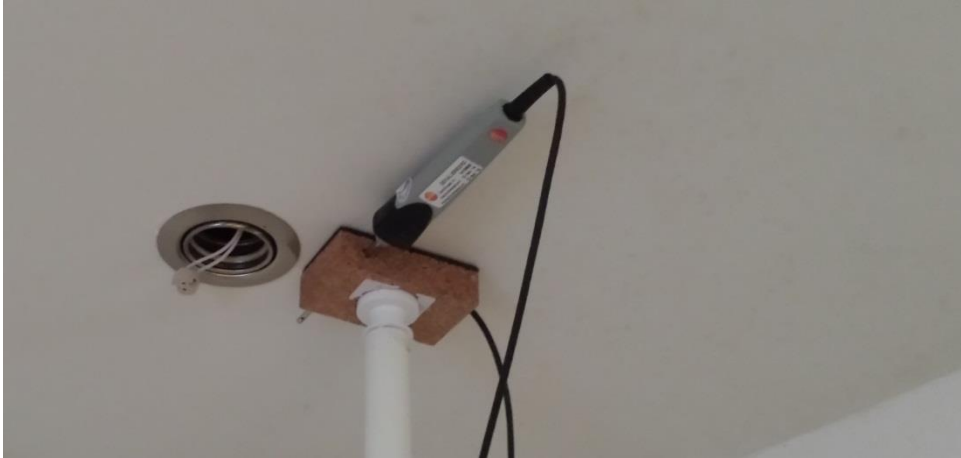
Foto A6: Meting van de plafondtemperatuur en de temperatuur 1 cm onder het plafond.
