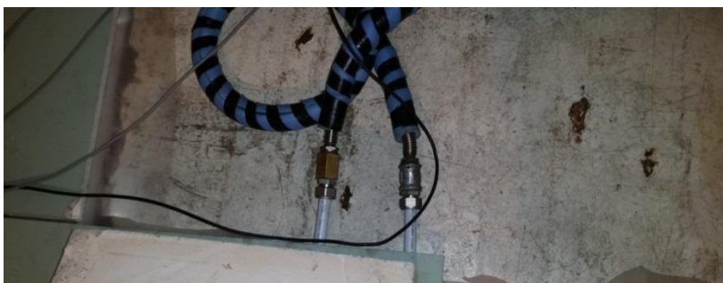
Foto 2.2 Aansluiting van vloerverwarming op aanvoer en retour van meetkamer
