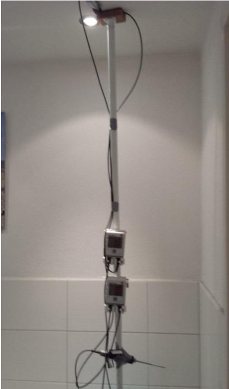
Foto 1.9 Plaatsing van de meetboom
