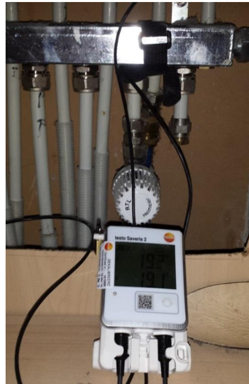
Foto 1.13 Plaatsing van de op de verdeler.
