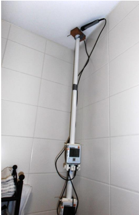
Foto 1.12 Plaatsing van de meetboom temperatuursensor
