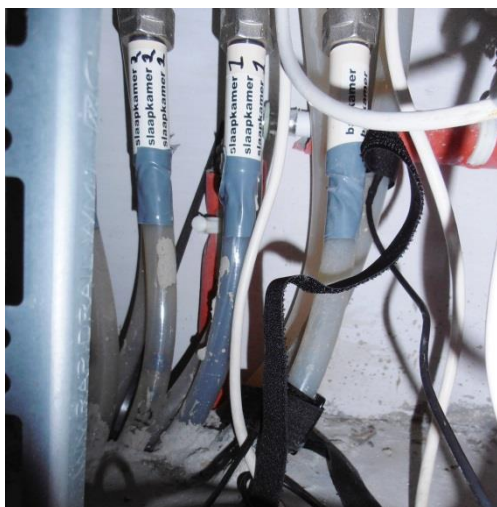
Foto 1.7 Plaatsing opnemers watertemperatuur. plafondtemperatuur
