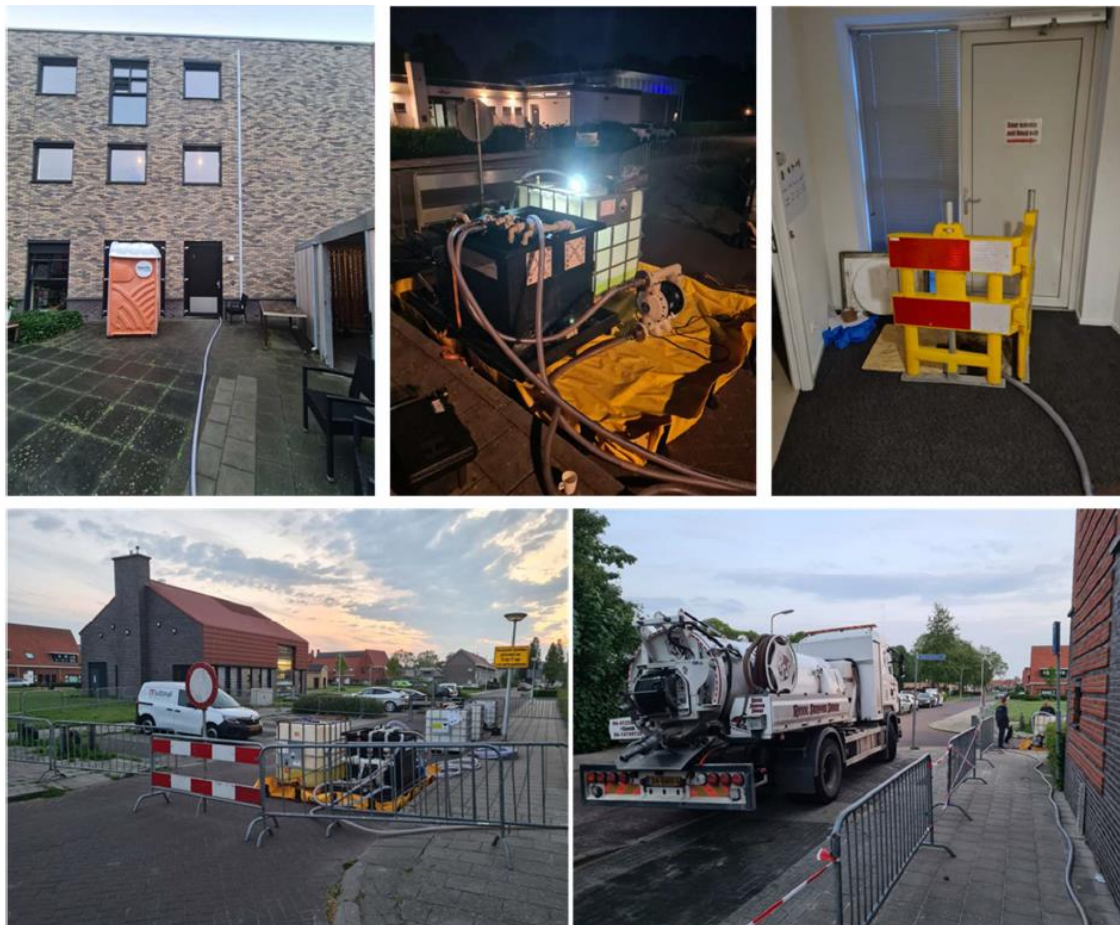
Figuur 2.5 Foto impressie van de uitvoering van de recirculatie
