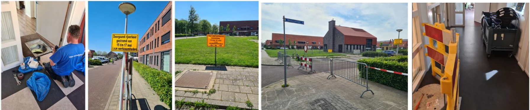
Figuur 2.3 Foto impressie van de voorbereidende werkzaamheden
