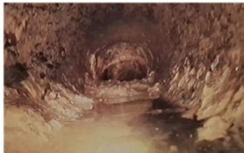
Figuur B4.8 Stukje verder net voor neerwaartse bocht ('pocket'). Op linkerfoto duidelijk dikke afzettingen zichtbaar
