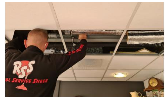
Figuur 4.8 Leiding in plafond groepsruimte op begane grond
