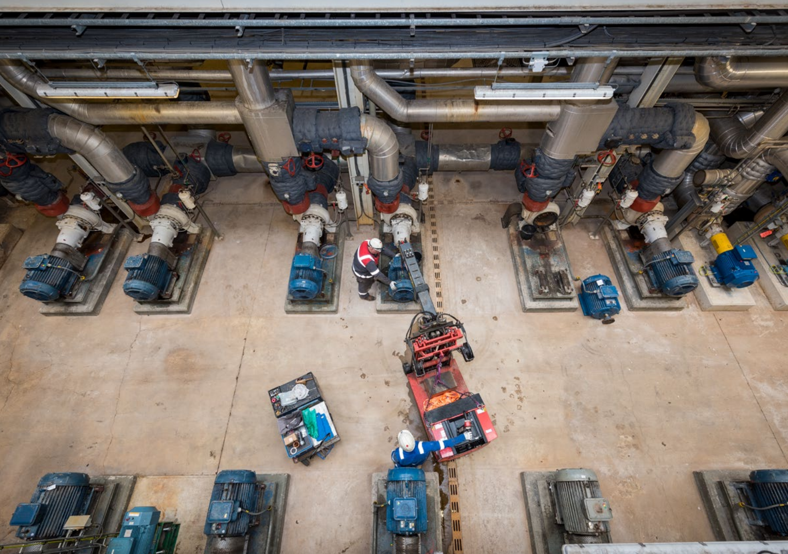
Het terugplaatsen van een gereviseerde centrifugaalpomp.
