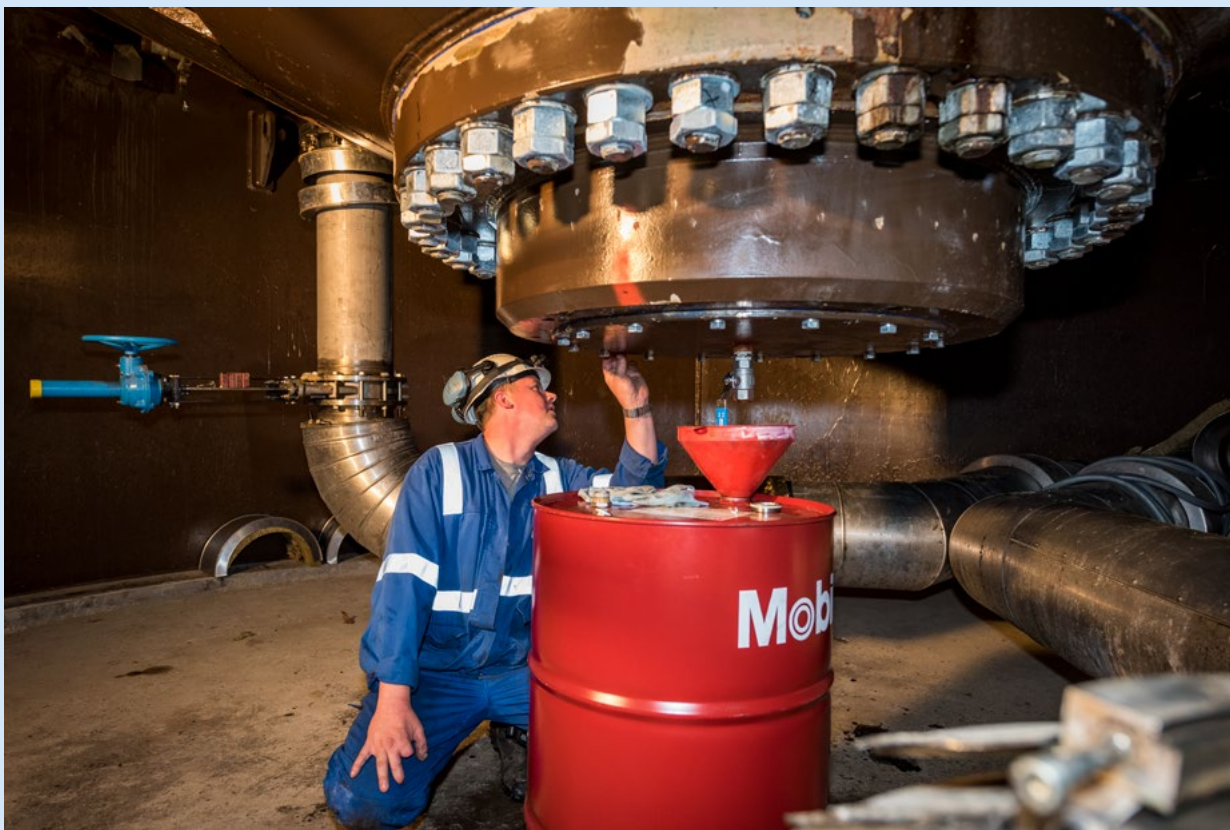
Monteur Tony inspecteert de afdichting van de lagerpot van de diffusietoren.
