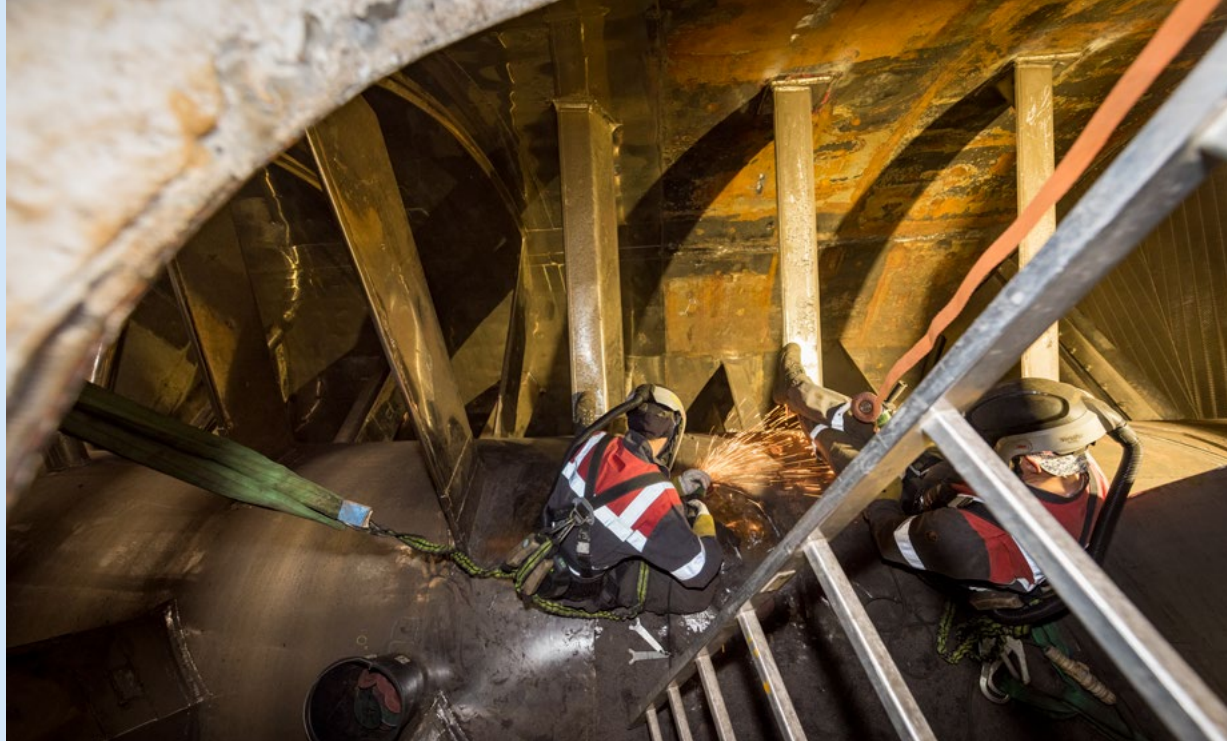
Contractor (TMS) aan het werk binnenin de broeitrog.
